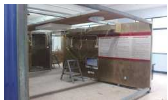
图三 照明电路安装平台
